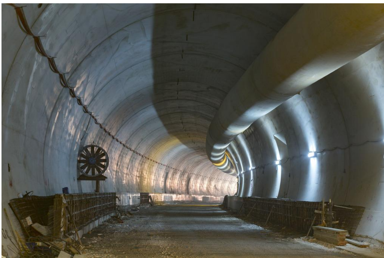
Εικόνα 11: Άποψη στην περιοχή της σήραγγας με μόνιμη επένδυση
