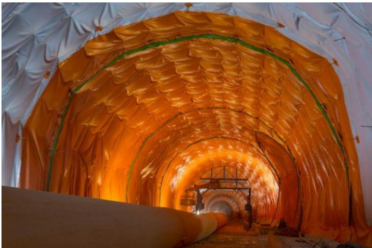
Εικόνα 8: Τοποθέτηση στεγανωτικής μεμβράνης
