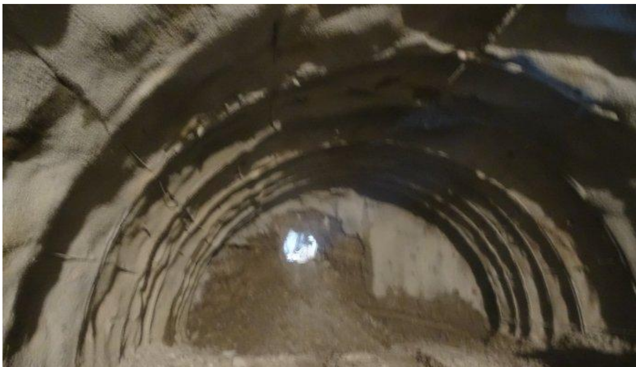
Εικόνα 1: Αμέσως μετά την ανατίναξη (για την εκσκαφή της απομένουσας μικρού πάχους βραχομάζας χρησιμοποιήθηκαν εκρηκτικά και δύο υδραυλικές σφύρες)
