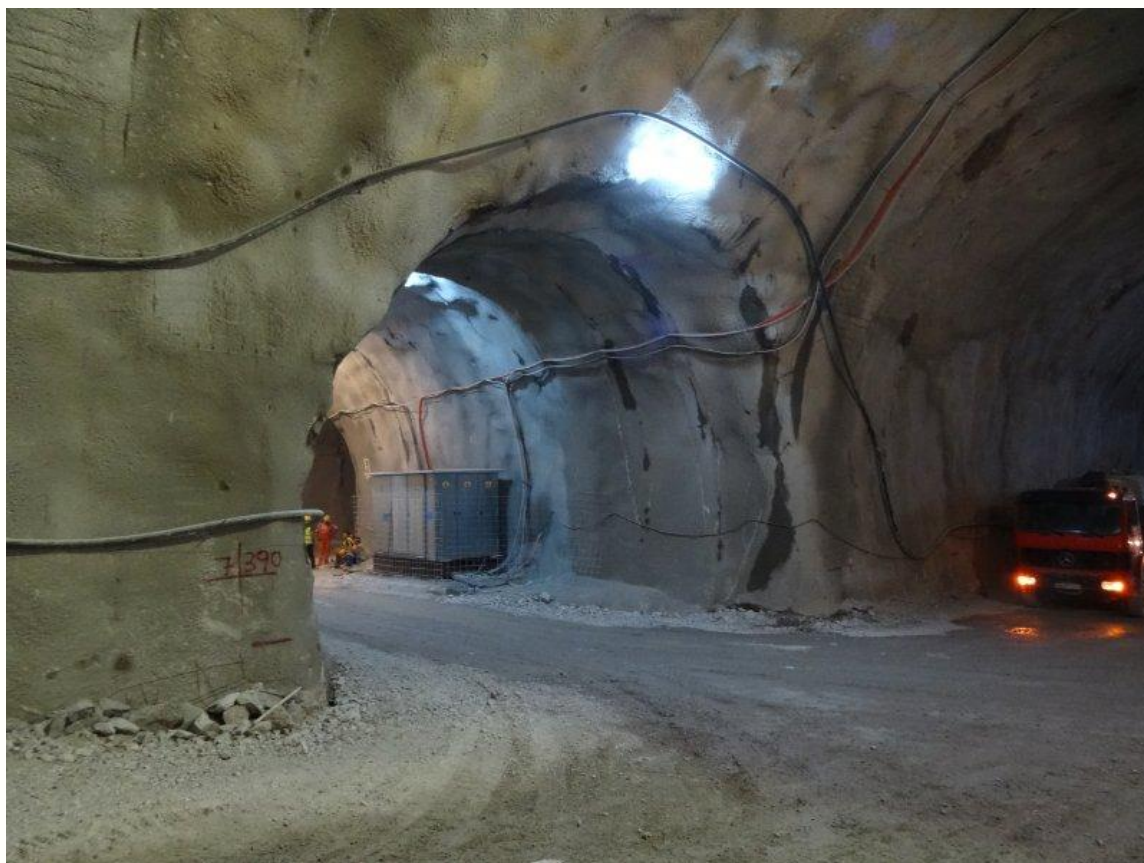
Εικόνα 5: Περιοχή συνδετήριων στοών
