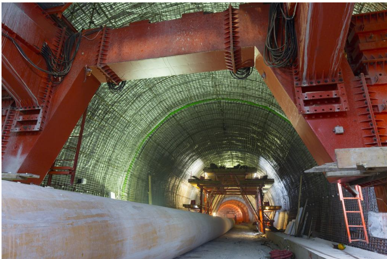
Εικόνα 12: Τοποθέτηση οπλισμού
