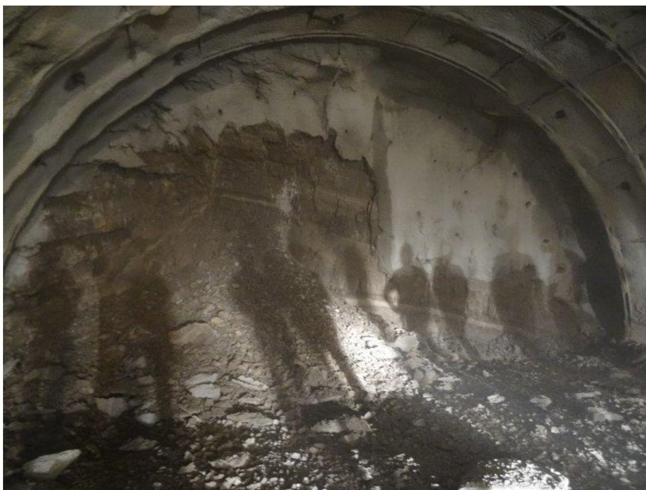
Εικόνα 2: Το μέτωπο αμέσως μετά την ανατίναξη
