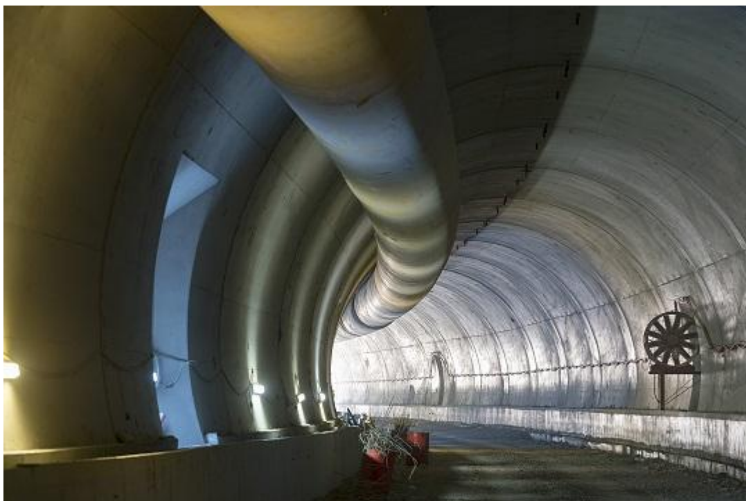
Εικόνα 10: Άποψη στην περιοχή της σήραγγας με μόνιμη επένδυση
