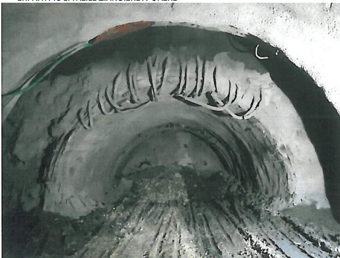
ΣΗΡΑΓΓΑ Τ3 ΔΙΑΚΡΙΝΕΤΑΙ Η ΠΙΛΟΤΙΚΗ ΣΗΡΑΓΓΑ
