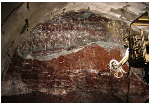
Εικόνα 6: Εμφάνιση ραδιολαριτών στο μέτωπο της σήραγγας Αρτεμισμού.
