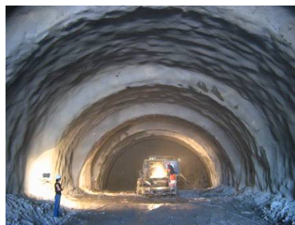
Εικόνα 2: Εκσκαφή άνω ημιδιατομής με χρήση δοκών προπορείας στο στόμιο εισόδου του αριστερού κλάδου της σήραγγας Αρτεμισίου.
