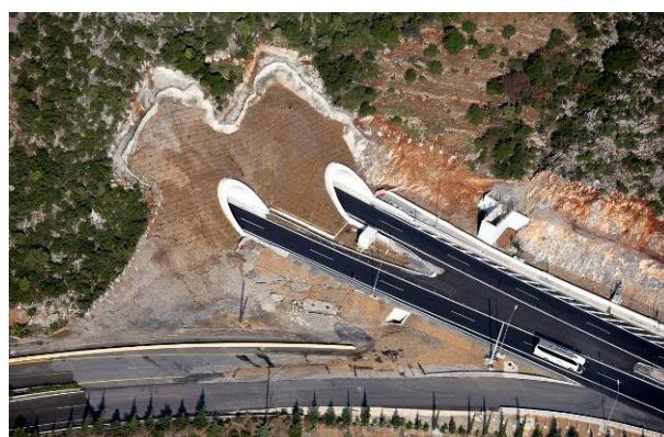
Εικόνα 22: Τα στόμια εισόδου της σήραγγας Νεοχωρίου.
