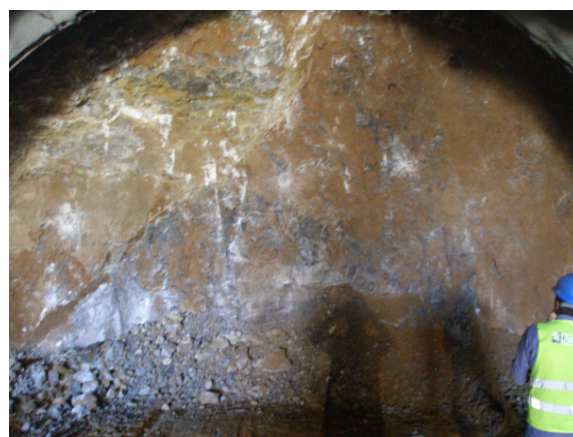
Εικόνα 17: Μέτωπο άνω ημιδιατομής σήραγγας Καλογερίκου. Ασβεστολιθική βραχομάζα με έντονη παρουσία αργιλικού υλικού.
