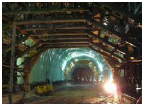
Εικόνα 3: Από τη φάση κατασκευής της άοπλης τελικής επένδυσης της σήραγγας Αρτεμισίου.
