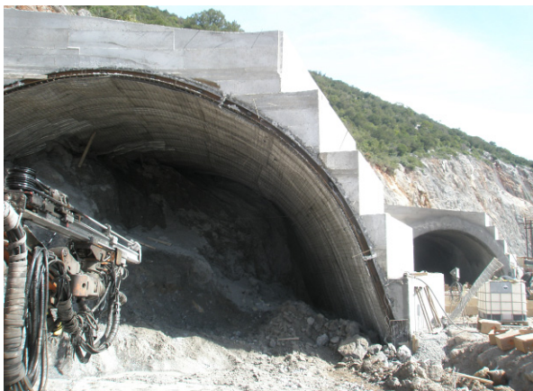
Εικόνα 14: Από την έναρξη των εργασιών εκσκαφής κάτω από το αντίβαρο του δεξιού κλάδου. Διακρίνεται το μεταλλικό πλαίσιο του σύμμεικτου εσωραχίου. Στο βάθος διακρίνεται το αντίβαρο του αριστερού κλάδου.
