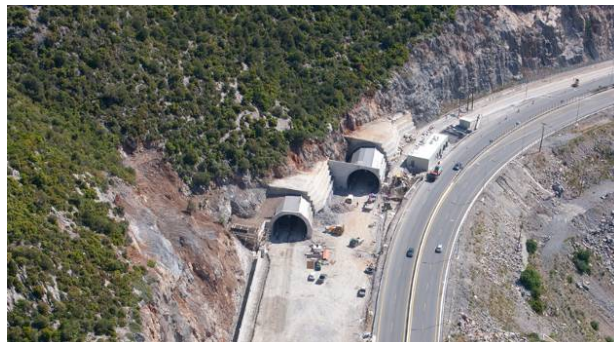
Εικόνα 11: Αεροφωτογραφία των στομιών εξόδου της σήραγγας Στέρνας. Διακρίνονται οι κατασκευές των αντιβάρων καθώς και η κατασκευή του Cut & Cover εξόδου.
