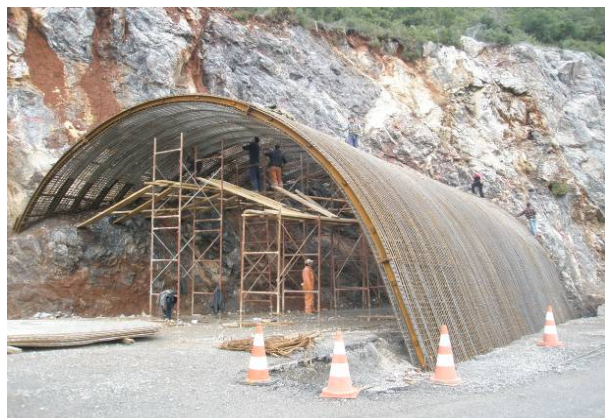
Εικόνα 13: Τοποθέτηση μεταλλικών πλαισίων και οπλισμού για την κατασκευή του εσωραχίου του αντιβάρου. Χρησιμοποιήθηκε εκτοξευόμενο σκυρόδεμα για την αποφυγή χρήσης μεταλλότυπου.
