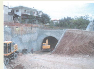
Στόμιο εισόδου της σήραγγας διαφυγής 1 στο Αίγιο
