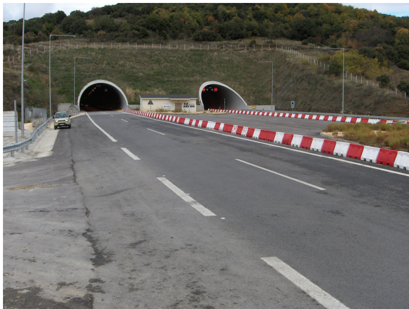
Νότιο Στόμιο (Είσοδος) Σήραγγας Δρίσκου
