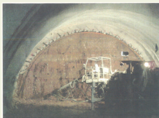
Προετοιμασία για εκτόξευση ινοπλισμένου σκυροδέματος στην σήραγγα Αιγίου
