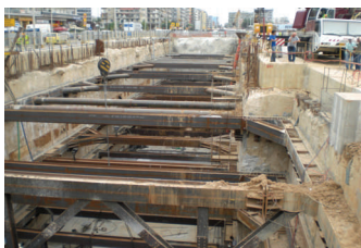
Νέος Σιδηροδρομικός Σταθμός
