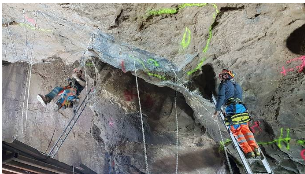
Αγκύρωση οροφής – Δεξιά: άποψη από τα ανατολικά κάτω δεξιά διακρίνεται το TBM
