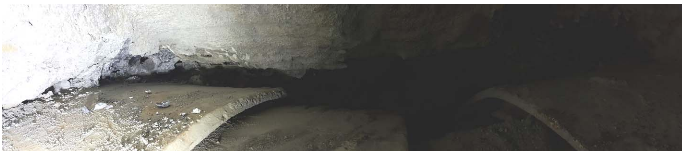
Καθαρισμός 1ης παγίδευσης TBM - θέση τηλεσκοπικής ασπίδας άνω και περιμετρικά
