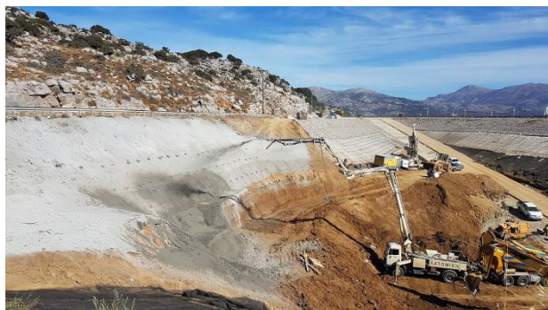
Περιοχή νοτίου μετώπου-Οροπέδιο Λασιθίου: Κατασκευή μετώπου εντός των αποθέσεων -αποκάλυψη TBM.
