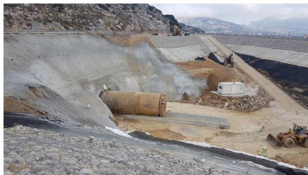
Περιοχή νοτίου μετώπου-Οροπέδιο Λασιθίου: Κατασκευή μετώπου εντός των αποθέσεων -αποκάλυψη TBM.
