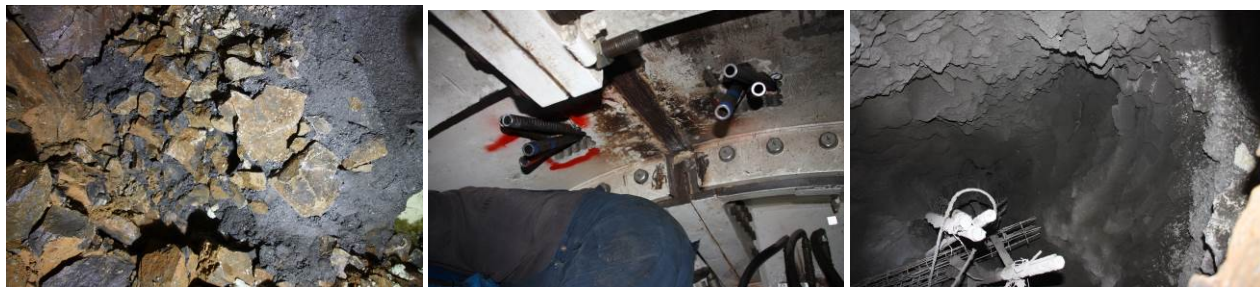
Χαλαρά υλικά έμπροσθεν κεφαλής μετά την σταθεροποίηση με ενέματα (I) Αγκύρια δια μέσου της πρόσθιας ασπίδας (II) Σταθεροποίηση υπερεκσκαφής με εκτοξευόμενο
