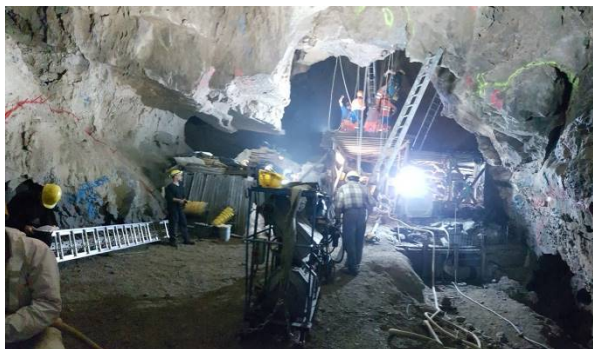
Αγκύρωση οροφής – Δεξιά: άποψη από τα ανατολικά κάτω δεξιά διακρίνεται το TBM
