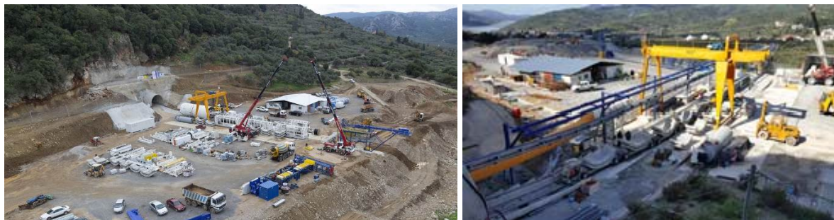
Αριστερά φάση εγκατάστασης TBM στο κατάντη μέτωπο - δεξιά φάση διάνοιξης, κατάντη μέτωπο συρμός μεταφοράς – συνεχόμενος ταινιόδρομος
