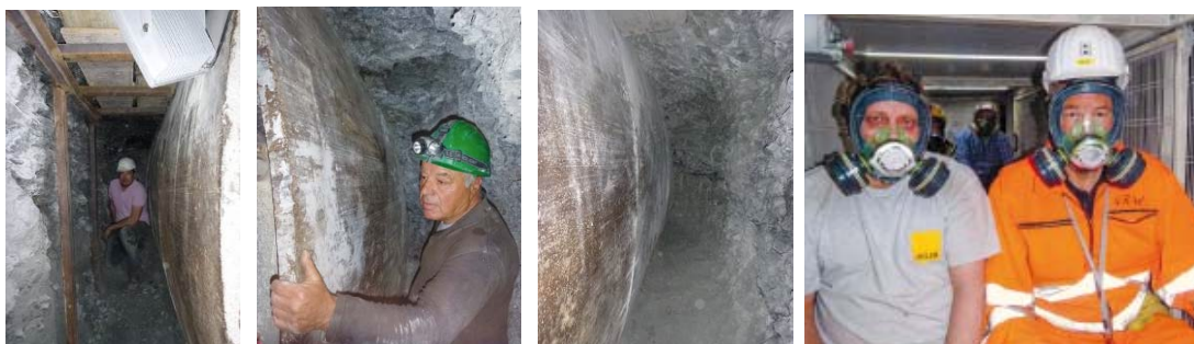
Καθαρισμός 2ης παγίδευσης TBM – πλευρικά στην οπίσθια ασπίδα (δεξιά-αριστερά-τηλεσκοπία)
